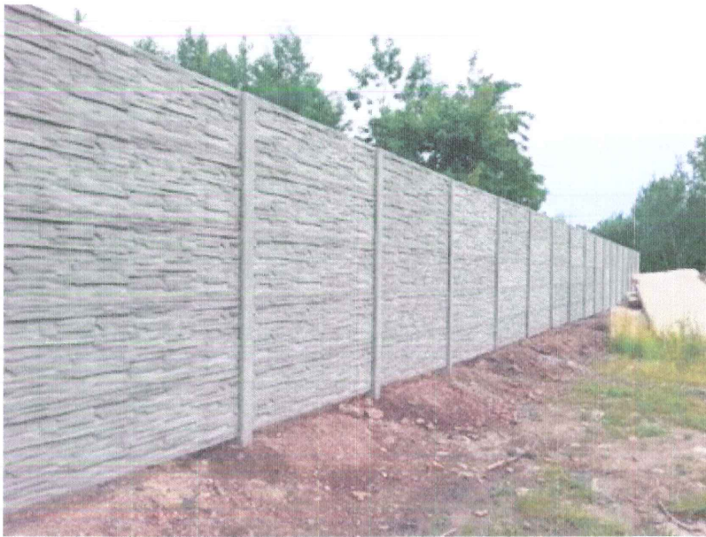
Rys. 12. Ogrodzenie z prefabrykatów betonowych o wzorze „łupek” – widok.
