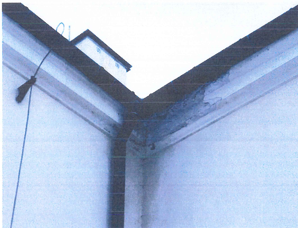
Fot nr 14 XVII-XVIII wieczny zespół klasztorny OO. Franciszkanów w Smardzewicach. Widok uszkodzenia gzymsu powstałego w wyniku dawnych nieszczelności załamania rynny.
