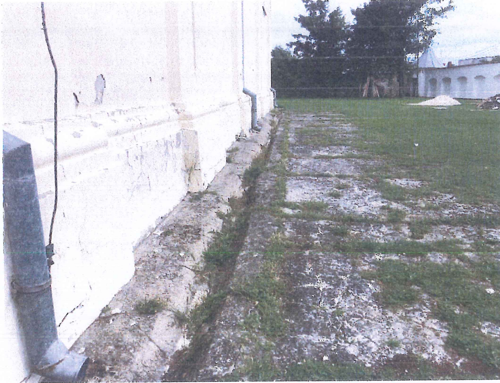
Fot nr 8 XVII-XVIII wieczny zespół klasztoru OO. Franciszkanów w Smardzewicach. Widok uszkodzeń warstw tynkarskich i malarskich w strefie cokołowej na elewacji południowej. Zniszczenia powstały w wyniku krystalizacji soli budowlanych i kumulacji wilgoci przez betonową opaskę.
