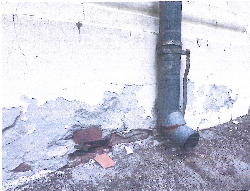
Fot nr 9 XVII-XVIII wieczny zespół klasztoru OO. Franciszkanów w Smardzewicach. Widok uszkodzeń warstw tynkarskich strony południowej powstałych w wyniku zastosowania nieodpowiednich zapraw cementowych podczas działań renowacyjnych prowadzonych w przeszłości.
