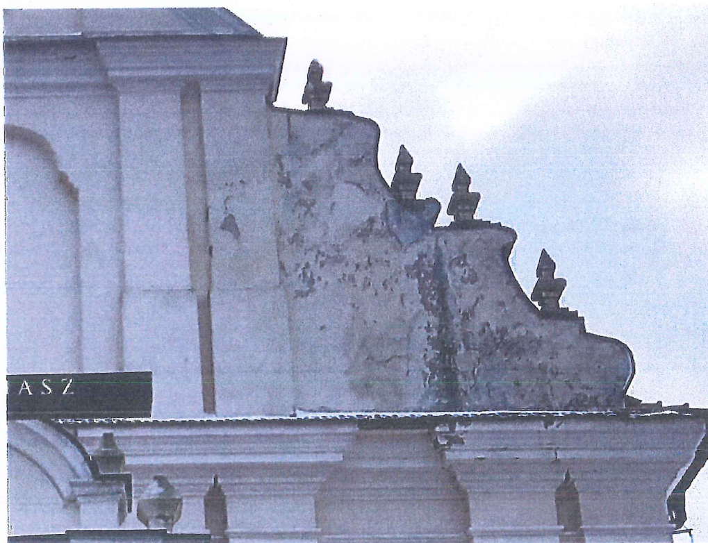
Fot nr 10 XVII-XVIII wieczny zespół klasztorny OO. Franciszkanów w Smardzewicach. Widok uszkodzeń warstw tynkarskich strony zachodniej powstałych w wyniku zastosowania nieodpowiednich zapraw cementowych podczas działań renowacyjnych prowadzonych w przeszłości.
