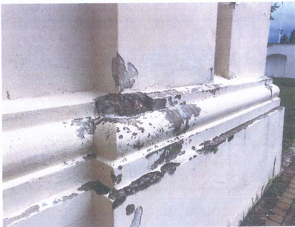
Fot nr 15 XVII-XVIII wieczny zespołu klasztoru OO. Franciszkanów w Smardzewicach. Widok uszkodzeń gzymsu cokołu powstałych w wyniku zastosowania nieodpowiedniej zaprawy cementowej.
