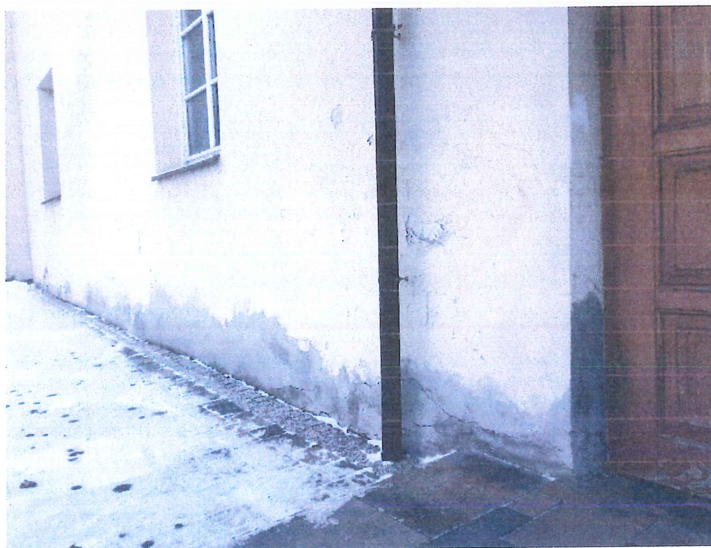
Fot nr 11 XVII-XVIII wieczny zespół klasztorny OO. Franciszkanów w Smardzewicach. Widok odznaczających się niewłaściwych napraw strefy cokołowej.
