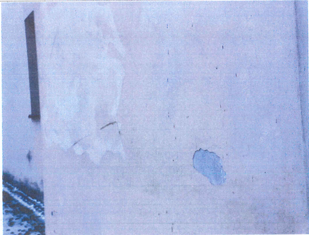
Fot nr 13 XVII-XVIII wieczny zespół klasztorny OO. Franciszkanów w Smardzewicach. Widok miejscowych odspojen tynku i warstw malarskich na elewacji zachodniej.
